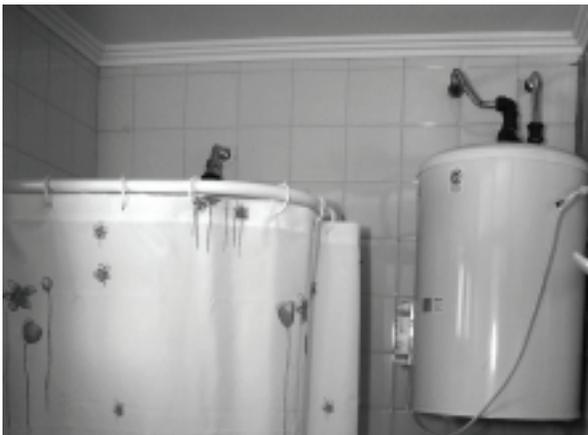
En los baños se eliminó el antiguo y perimido sistema de agua caliente, colocando un termotanque eléctrico por cada unidad.
