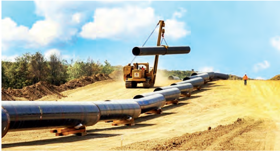
La obra del Gasoducto en la zona de trazado pampeano, demandará hasta 600 puestos de trabajo. Entre los campamentos a instalarse en la Provincia por parte de la empresa BTU SA, además de Casa de Piedra, 25 de Mayo, Chacharramendí y Doblas, tendrá un importante obrador en Macachín, donde ya se movilizan para conseguir personal.
