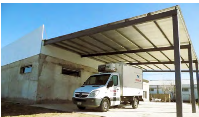
Obra en marcha en el Parque Agroalimentario de Pico.
