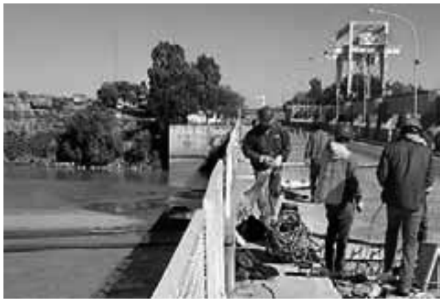
Las obras de reparación, con una inversión de $ 3 millones, estarían terminadas los primeros días de junio.
