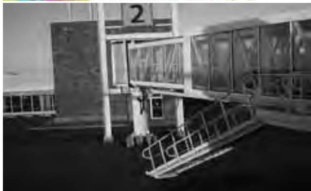
La terminal aérea de Santa Rosa es demasiado pequeña, con escaso espacio, ofrece poca comodidad a los pasajeros y acompañantes. No tiene sala de preembaque que ni tampoco mangas telescópicas para embarque (foto de otro aeropuerto).
